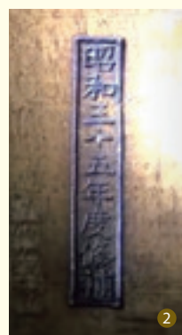
① 小屋裏の構造部材を説明する工学系研究科の藤田香織先生。② 昭和35年度改修時に取り替えられた部材の刻印。
